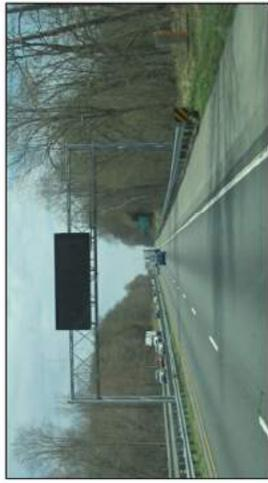
TYPICAL DMS INSTALLATION ON TRUSS STRUCTURE
