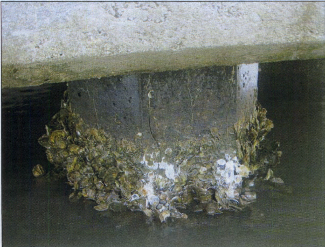
BENT 6 P-2 F-3 H/L - 1/16" CRACK
