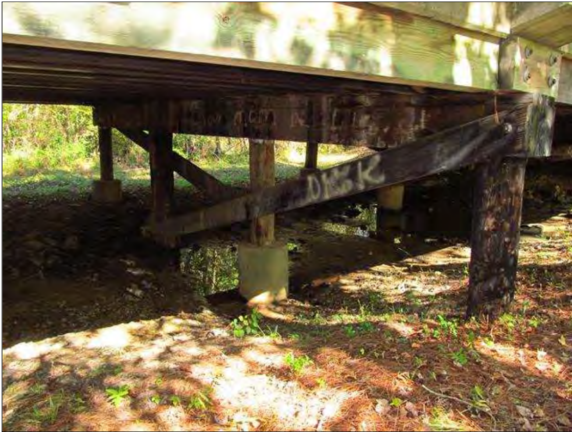
Bent 6 Span 6 side
