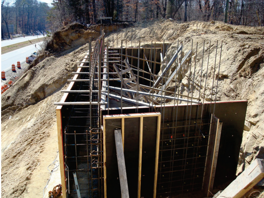
Figure 3-28. Thomasville End Bent 1 mass concrete pour
