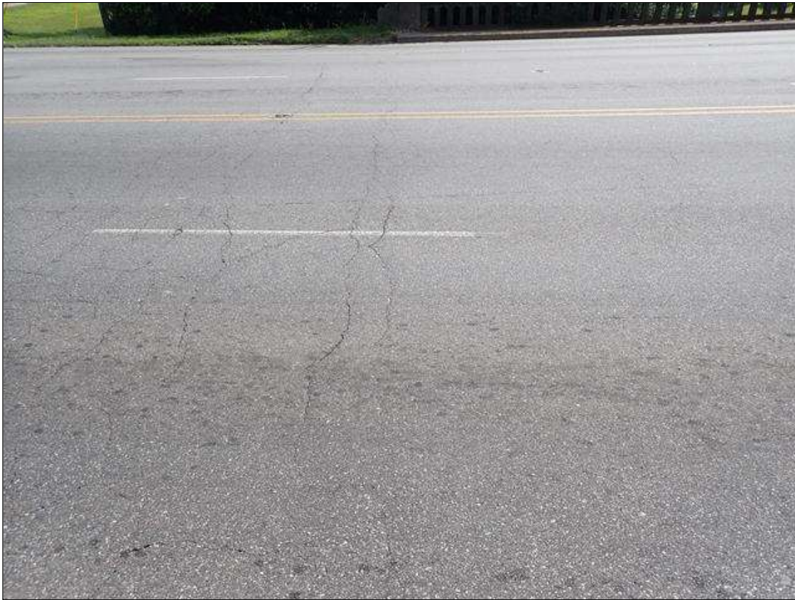
end bent 2 asphalt
