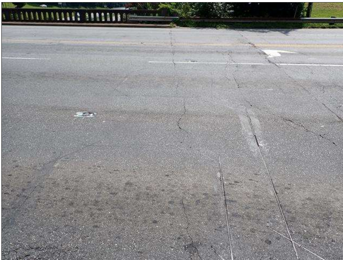
end bent 1 asphalt
