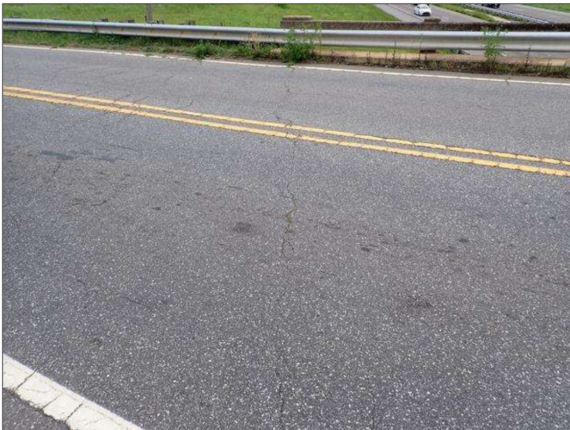
end bent 2 asphalt
