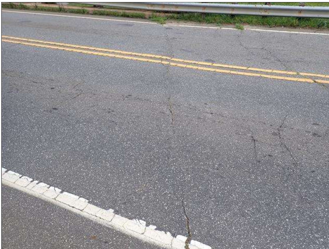
end bent 1 asphalt
