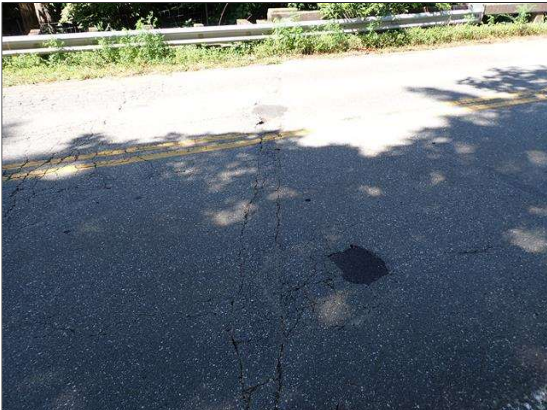
end bent 1 asphalt
