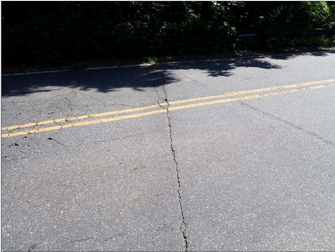
end bent 2 asphalt
