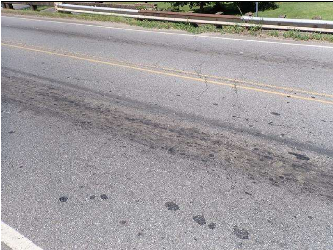
end bent 2 asphalt
