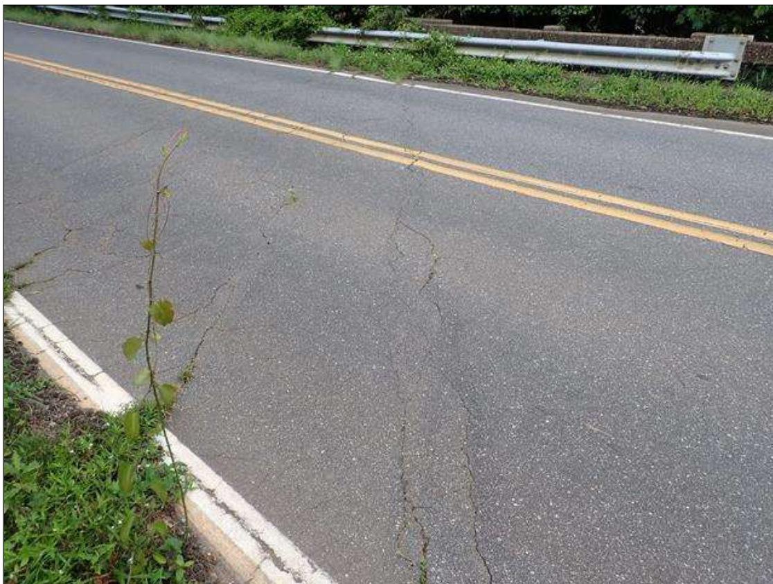
end bent 1 asphalt
