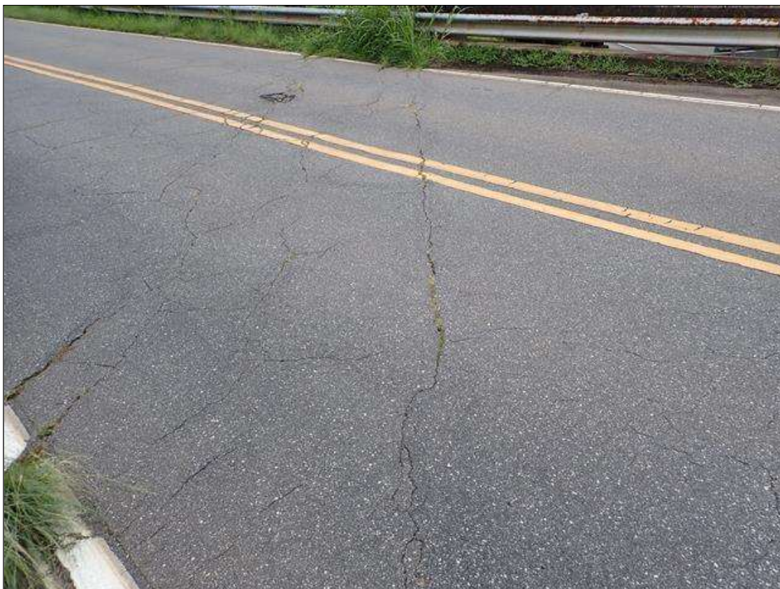
end bent 2 asphalt
