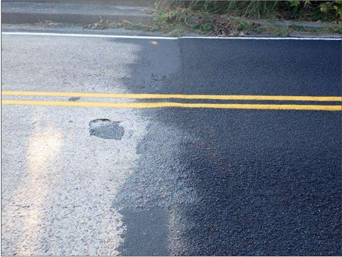
end bent 1 deck (end bent 2 similar)
