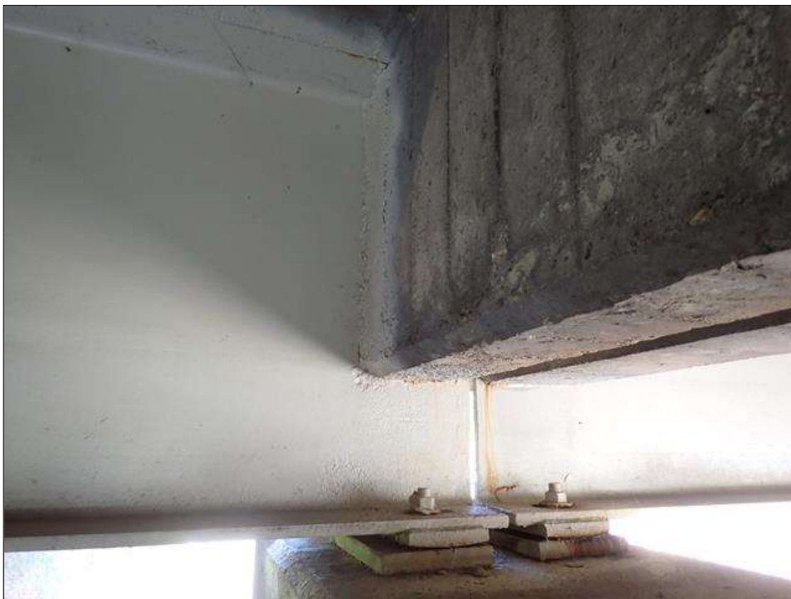
exterior beams over bent 1 (bent 3 similar)
