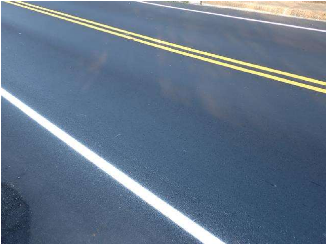
end bent 1 asphalt
