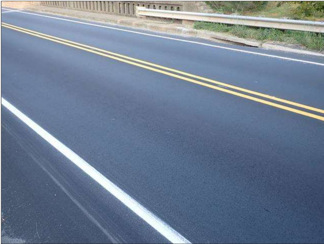
end bent 2 asphalt
