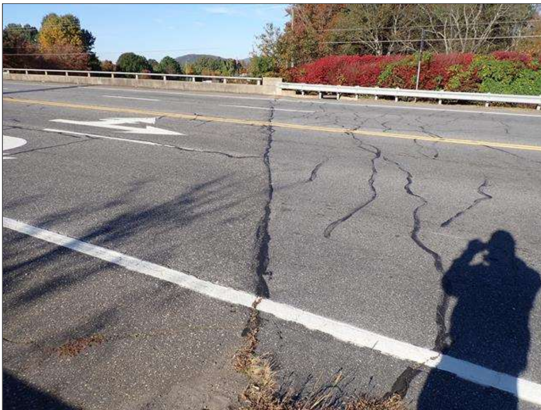
end bent 2 asphalt
