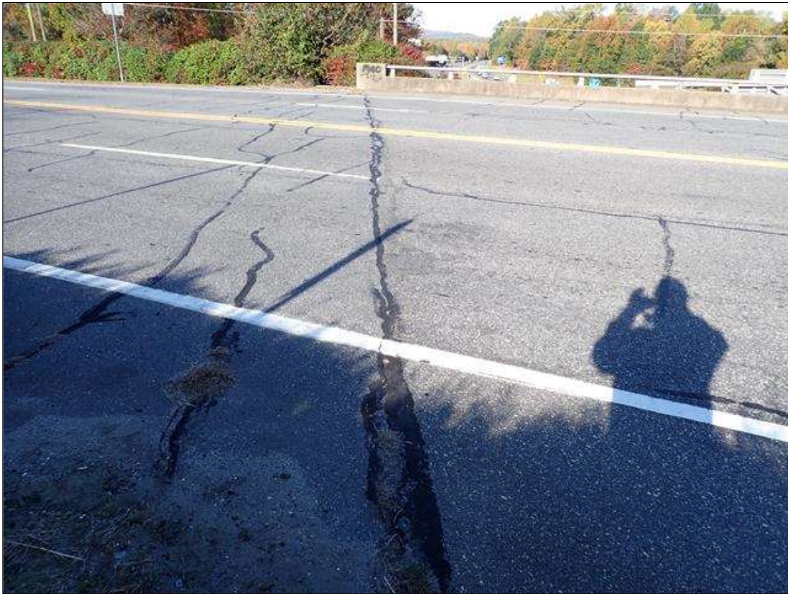
end bent 1 asphalt
