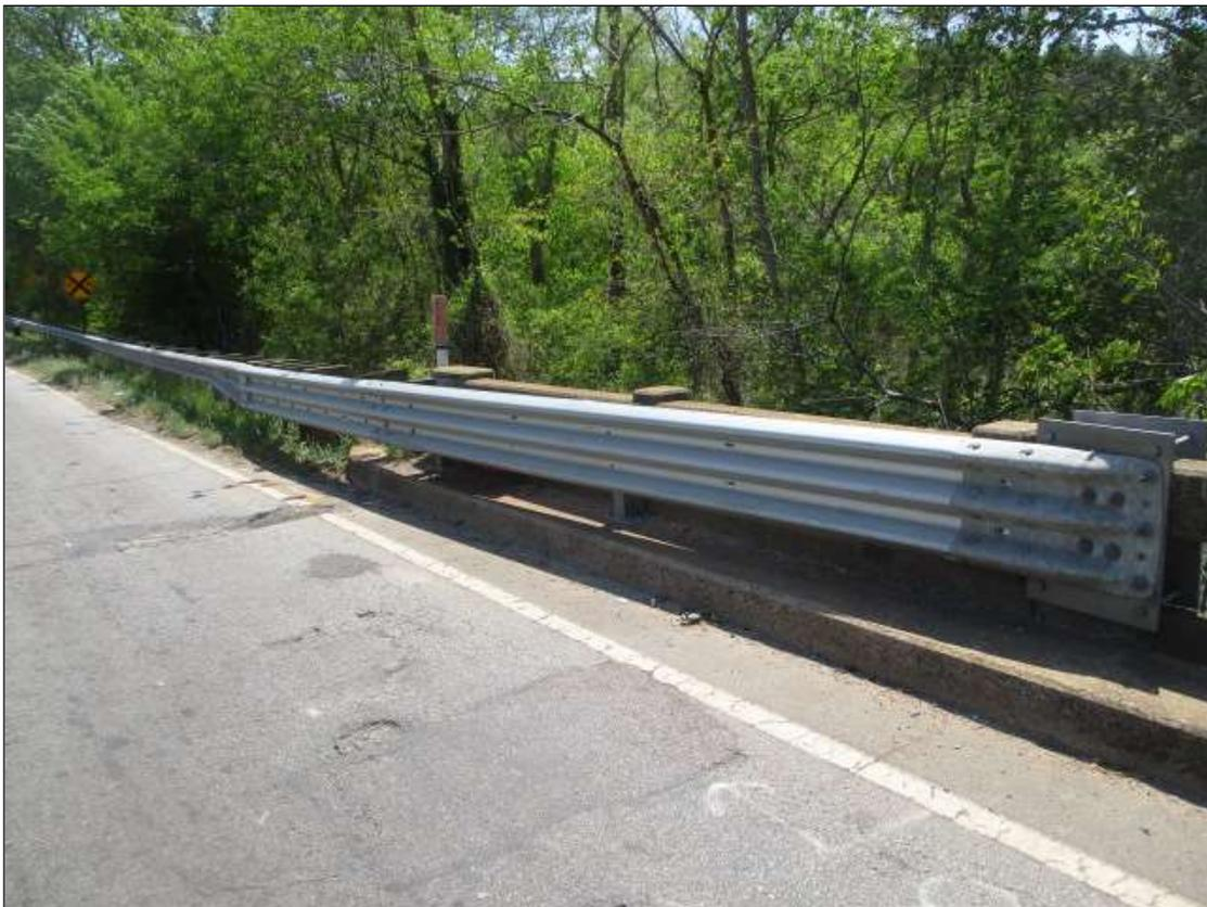
TYPICAL GUARDRAIL CONNECTION
