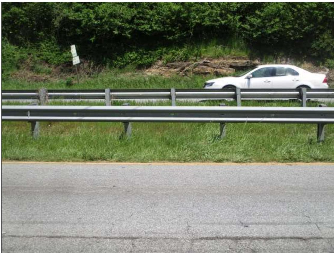
TYPICAL APPROACH GUARDRAIL POST SPACING
